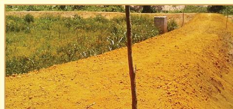
Digue réalisée avec de la bonne terre, argileuse
