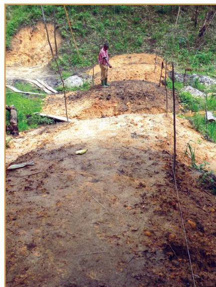
Digue en construction et piquets de remblai
