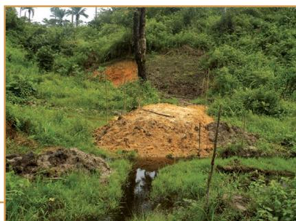
*Construction de la digue d'abord en largeur, puis en hauteur et en longueur.*
