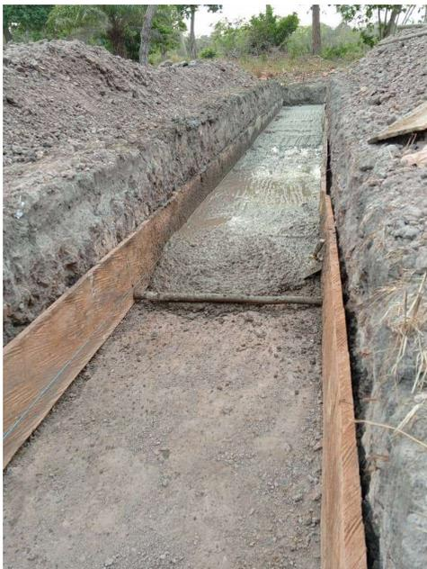
*Coulage du béton de la semelle avec coffrage*
